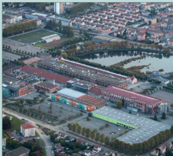
Le projet s'inscrit au cœur du Techn'hom avec, entre autres, l'installation de panneaux photovoltaïques pour alimenter les bâtiments en électricité. Photo ER/Michael DESPREZ
