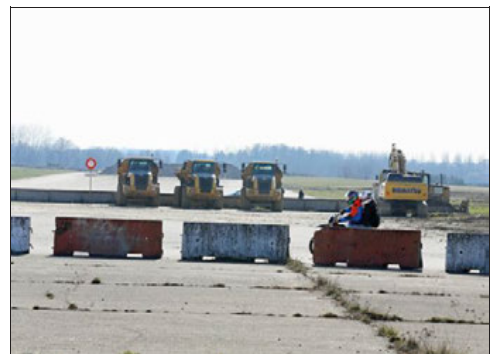
Les travaux en cours pour le plus grand parc solaire de Franche-Comté sur le site de l'Aéroparc de Fontaine. Photo ER/Christine DUMAS
